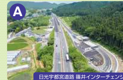
日光宇都宮道路 篠井インターチェンジ 生活道路として使えるようになりました。
