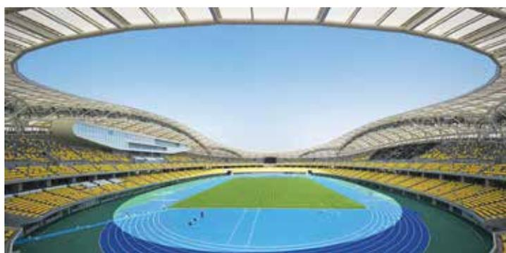
屋根は6枚の桧の葉を重ねたイメージの印象的な白い膜屋根を使用しており、緩やかな曲面を持った形態をアーチ効果として利用したトラス構造としています。
